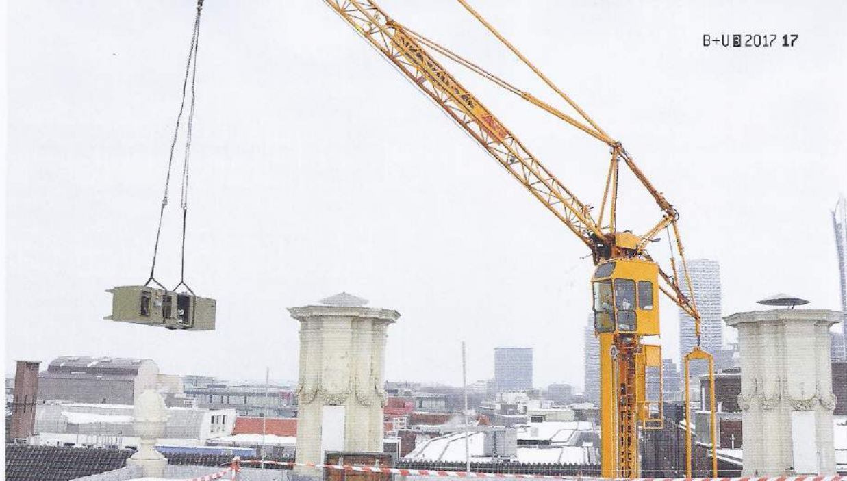
▲ DE OUDE KLIMAATINSTALLATIE IS VIA HET DAK VERWIJDERD
